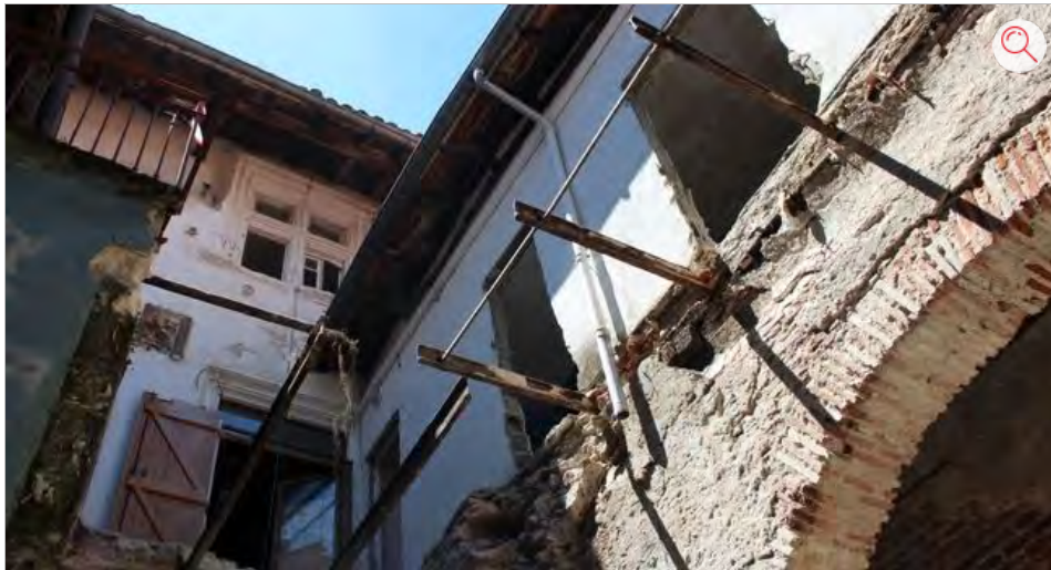
La rue du Château du roi au cur des projets de réhabilitation. Les travaux sont lancés./Photo DDM, Jade Cosse.
